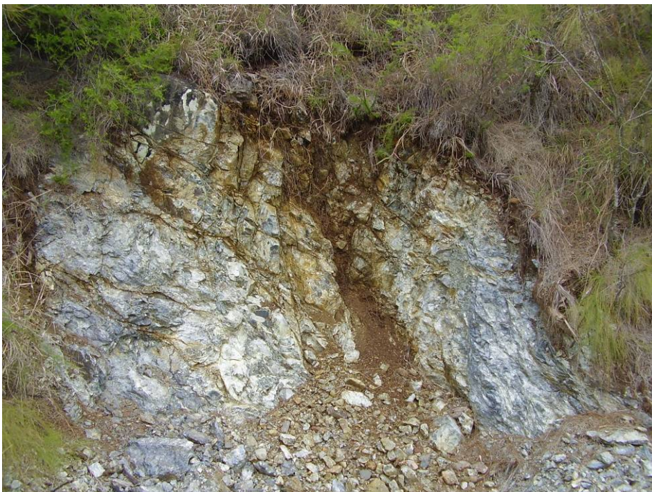
Photo 13 : Talus de terrassement dans des formations de serpentinite, tribu de Nedivin, commune de Houaïlou
