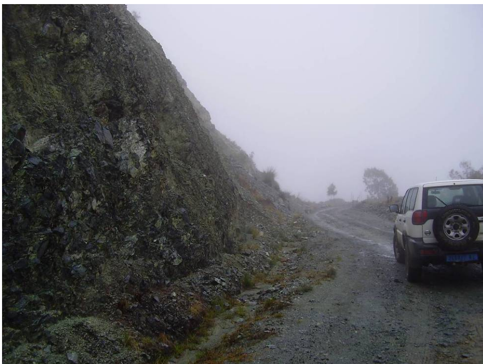
Photo 25 : Talus routier constitué de serpentinite, éboulis en pied de pente et piste recouverte de serpentine, entre Bas Coulina et Ouyagette, commune de Hienghène
