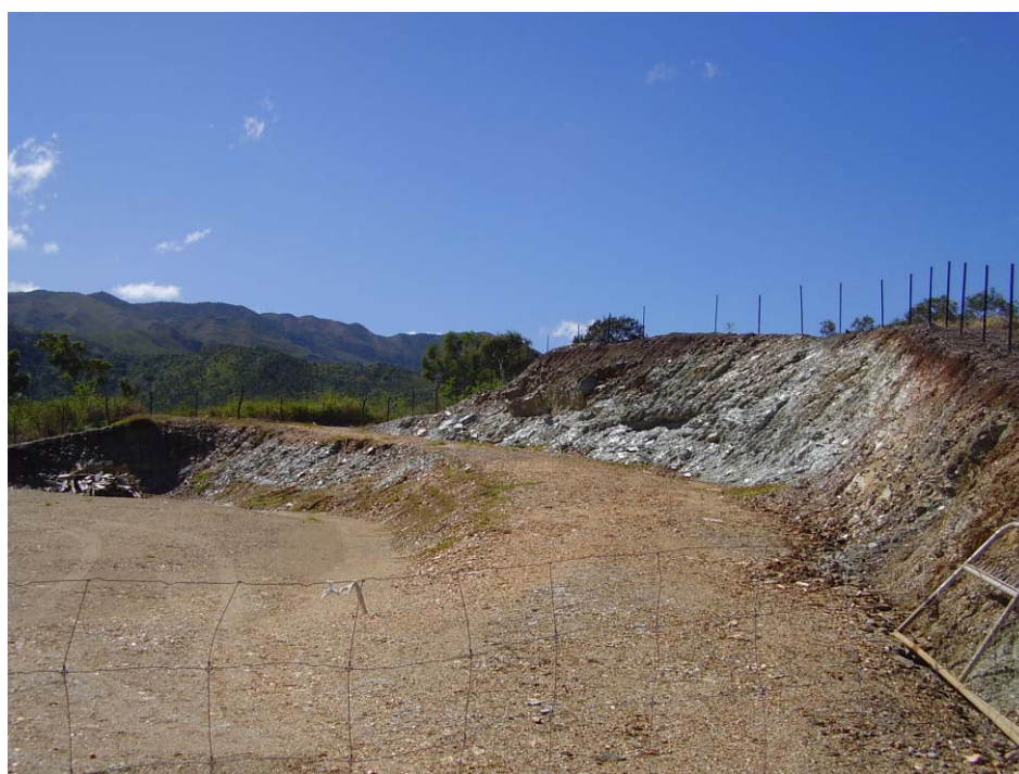
Photo 11 : Plateforme pour un lotissement dans des formations de serpentinite, commune de Ouégoa
