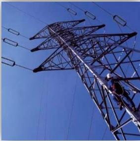
Le réseau de transport 150 000 volts achemine l'énergie produite par les centrales de Yaté, Néaoua, Doniambo, Prony, Népoui, Ducos et KNS vers les postes sources d'interconnexion 150/33 kV dans lesquelles sa tension est abaissée. Elle est alors envoyée sur les réseaux de répartition 33 000 volts.
