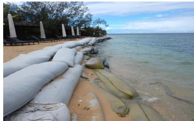
Artificialisation du rivage (sacs de sable, reprofilage etc.) d'un îlot visant à réduire l'érosion (îlot Canard, Nouméa, 2016)
