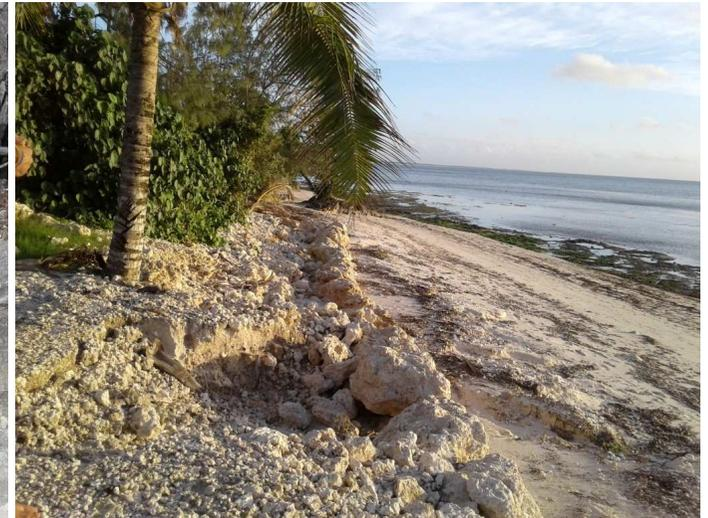
Exemple du cordon d'enrochement existant au sud de Hwadrilla → **construction récente / dégradation prononcée en plusieurs points**
